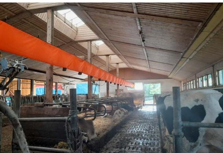
Schlauchsysteme bringen Frischluft in den Liegebereich Foto: I. Mösenbacher-Molterer
