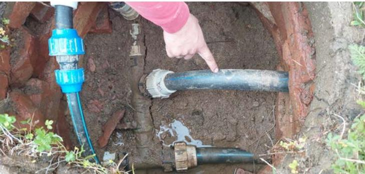
Bei den Verteilerschächten werden die oberirdischen Verteilereinheiten (7 Regnerlanzen mit Schläuchen in Serie verbunden) angeschlossen
