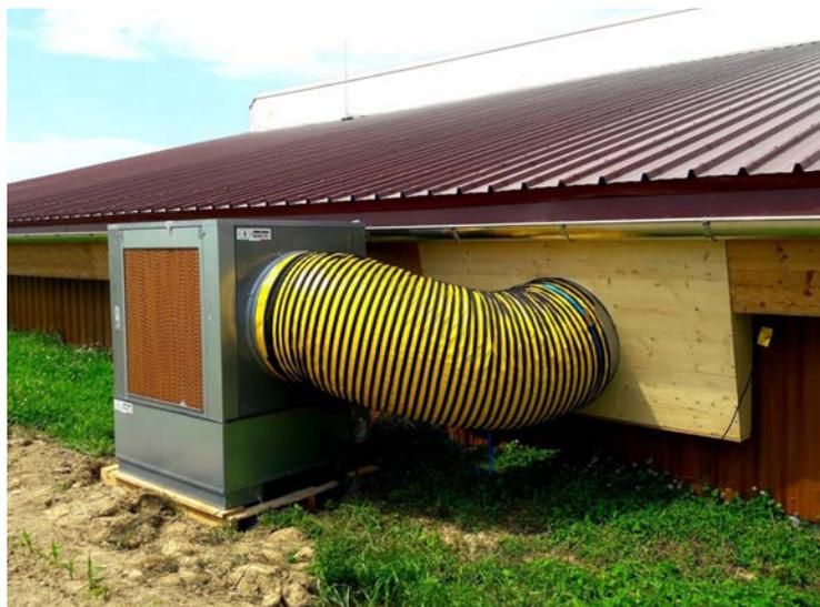
Cool-Pads können relativ einfach in Ställen integriert werden, um Zuluft zu kühlen
