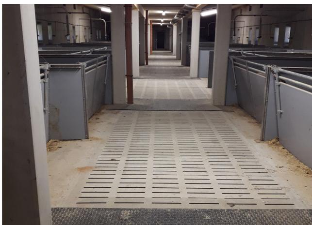
Großzügig dimensionierte Unterflurkanäle nutzen die Kälte im Erdreich als Puffer
