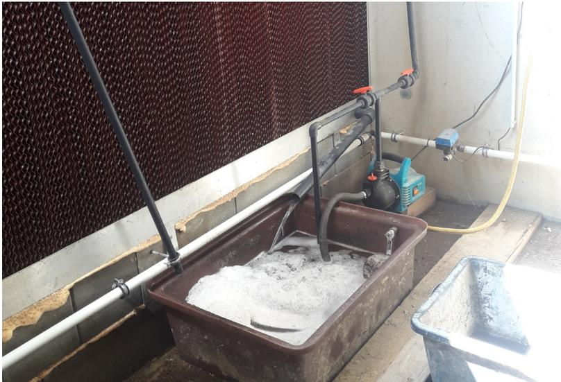
Bei Coolpads werden Zellulosewaben mit Wasser berieselt
