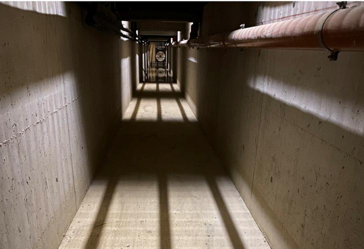
Großzügig dimensionierte Unterflurkanäle nutzen die Kälte im Erdreich als Puffer
