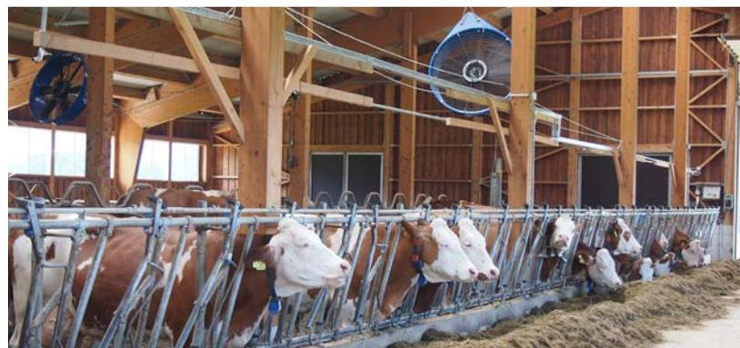
In Milchviehherden kommt einer ausreichenden Kühlung besondere Bedeutung zu. Die Steuerung von Ventilatoren durch einfache, temperaturabhängige Regelschalter stellt bereits eine sehr wirksame Automatisierung dar
