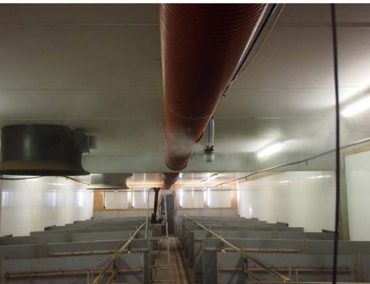
Kühlung der Stallluft durch Zweistoffdüsenteknik
